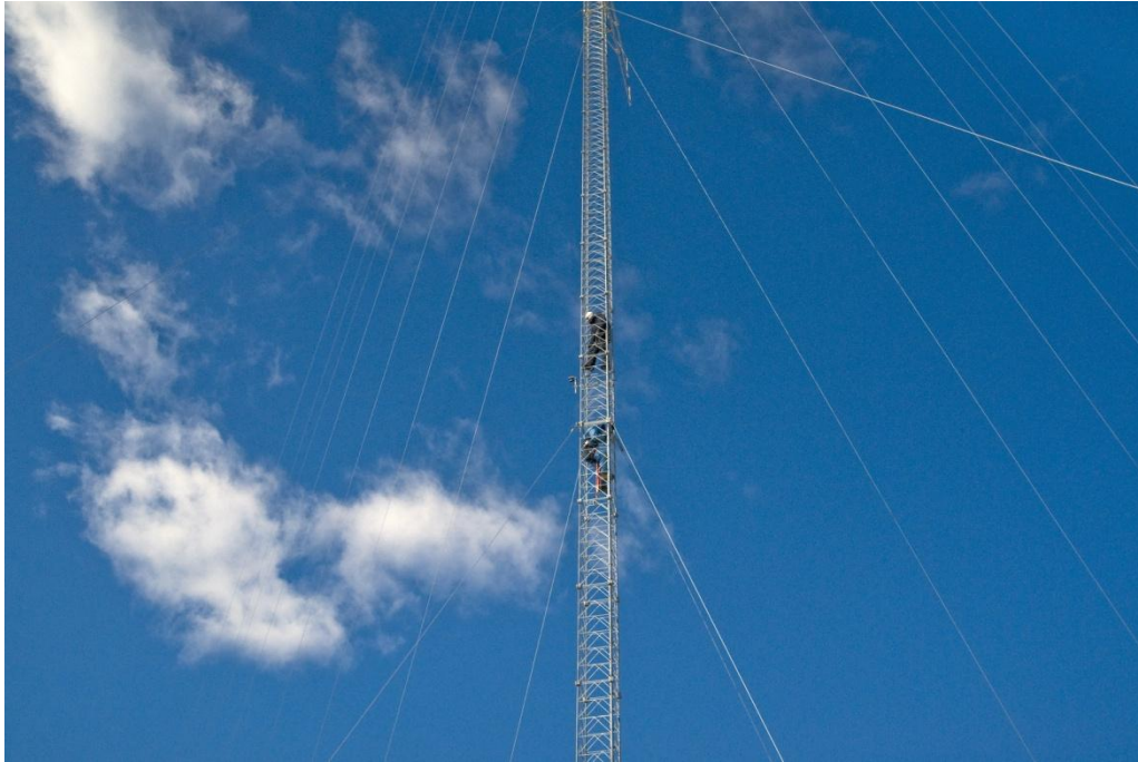
Underhållsarbete på en av vindmätningmasterna.
