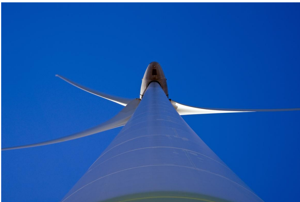
Vindkraftverk på Dragaliden i underifrånperspektiv.
